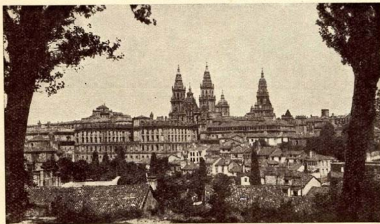
VISTA PARCIAL DE COMPOSTELA
